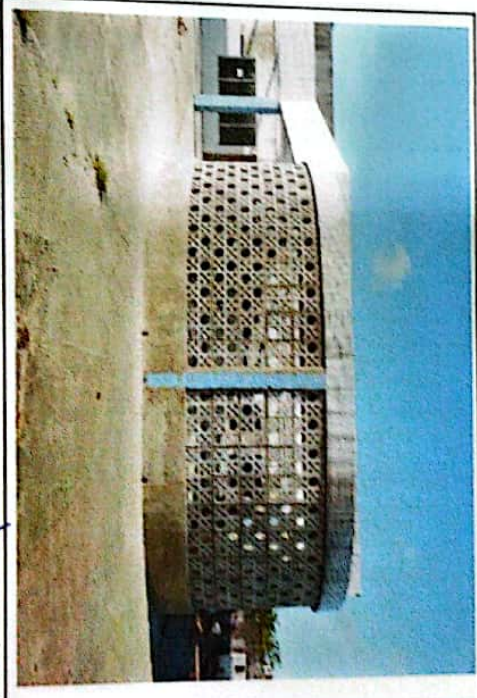
ASSENTAMENTO CERÂMICO - PAREDE FRONTAL
